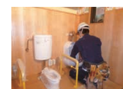
住設機器等取付け
