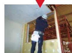
鋼製建具取付け
